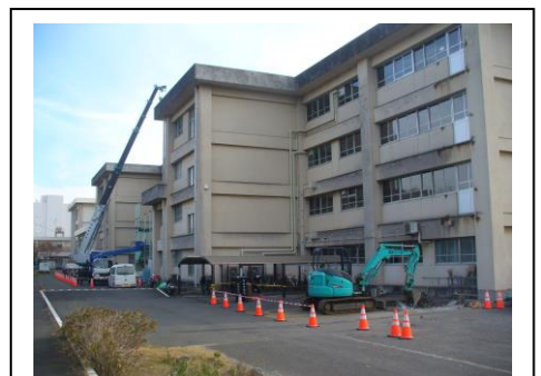
非常階段が撤去されました
